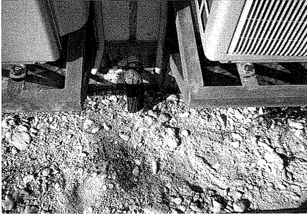
クーラー室外機の水が落ちる部分に埋めたモンパの玉切
