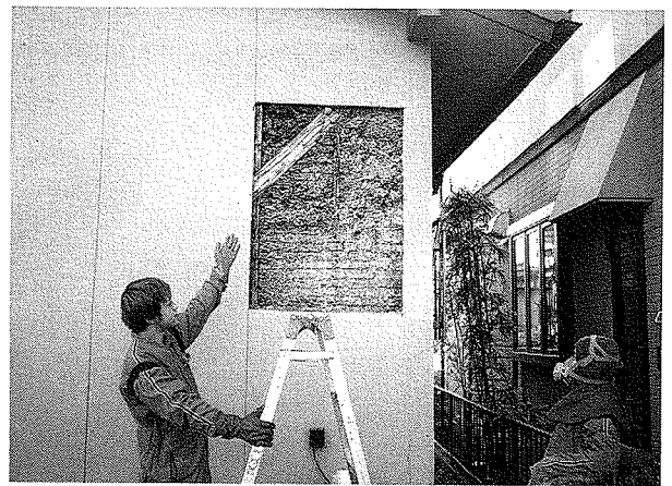
写真1 住宅の壁の中に造ったイエシロアリの巣（熊本市）
