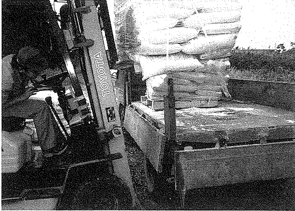
写真1 防除施工用品の運搬作業
