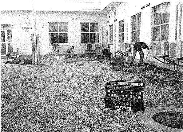
写真5 管理棟周辺のシロアリ防除施工をしているところ
