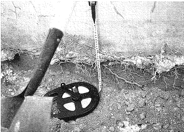
写真3 掘削深さを確認しているところ
