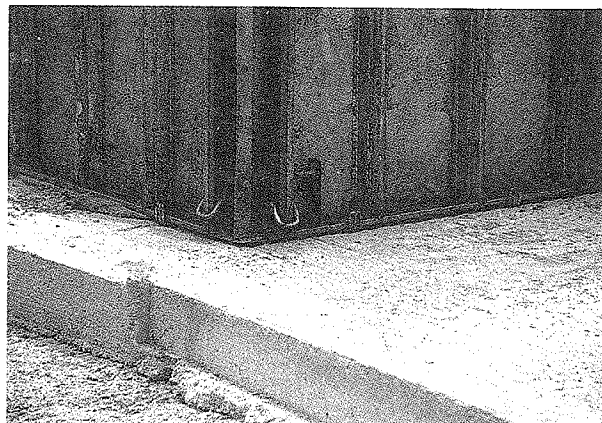
写真19 型枠抑え金具設置状況（下部）
