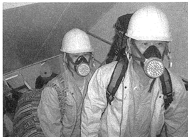
ガスマスクを装着しての作業
