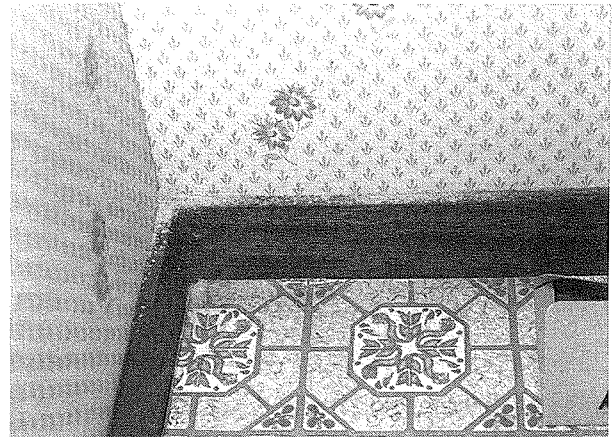
写真7 ヒラタキクイムシに食害された壁材から排出され、堆積した虫粉
