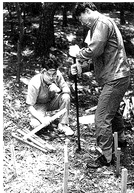
写真1 試験杭の設置
