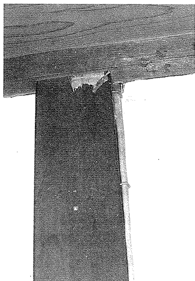
写真16 木造建物和室の柱上部のアメリカカンザイシロアリによる被害
