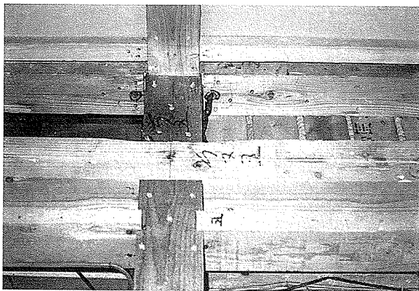
写真20 穿孔処理において穿孔された二階和室床下の構造材
