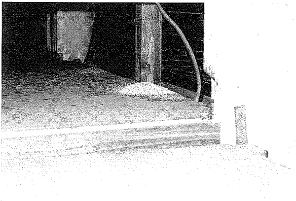
写真7 木造建築物の天井裏に堆積していたアメリカカンザイシロアリの糞
