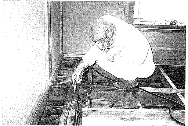
写真21 木材に穿孔された穴に薬液を注入しているところ
