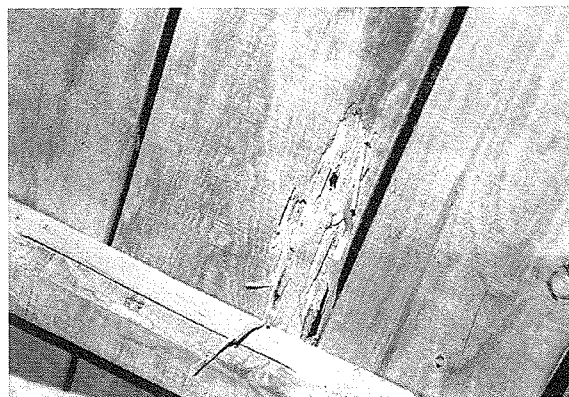
写真12 アメリカカンザイシロアリによる野地板の被害
