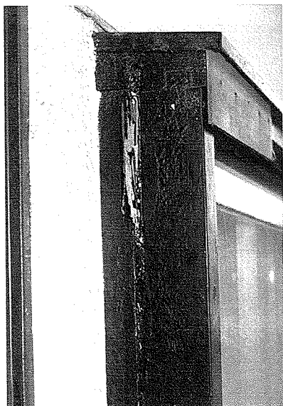
写真10 木造建物1階窓枠のアメリカカンザイシロアリによる被害
