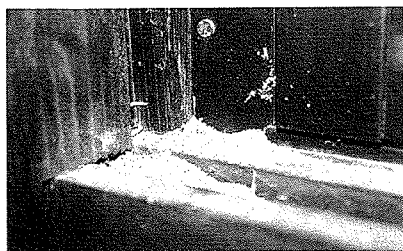
写真8-12 アメリカカンザイシロアリによる被害
