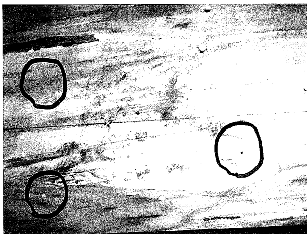
写真7 宇和島市B邸松ハリの被害 ハリの表面に1mm印虫孔は幼虫のもの、他は成虫の脱出孔（5～7mm） H18.8.23調べ
