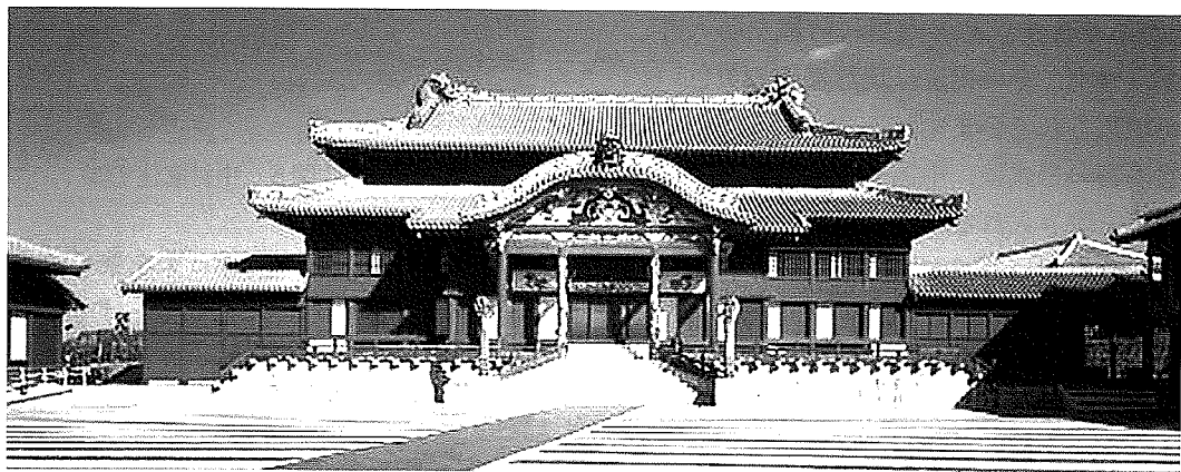
図8 復元された首里城正殿
