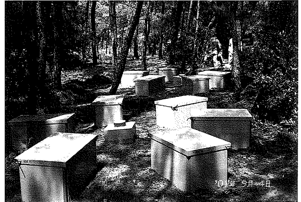
写真5 断熱材料のセットが完了したPVC箱
