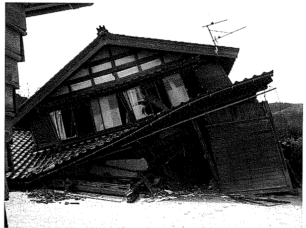
写真1 倒壊した建物 (旧門前町道下地区)
