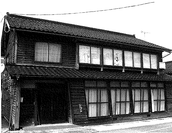
写真3 一階部分が大きく変形している建物 （旧門前町道下地区）
