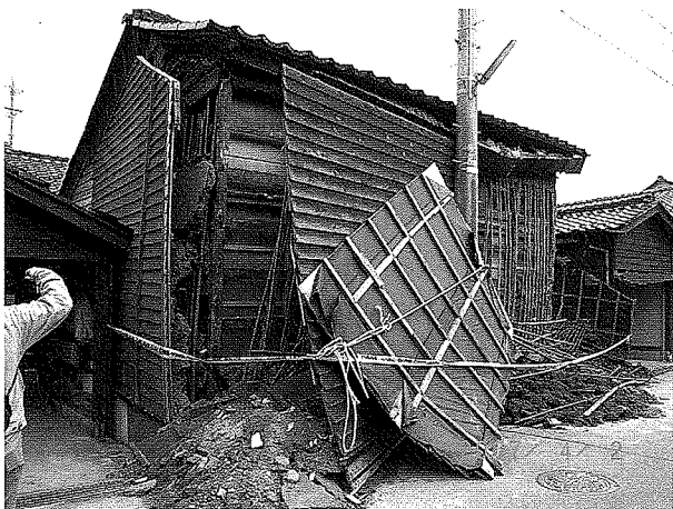
写真6 電柱に寄りかかっている土蔵 (旧門前町黒島地区)
