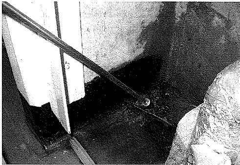
写真26 3階床取合部吹付処理
