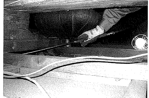
写真27 2階天井木毛板薬剤注入
