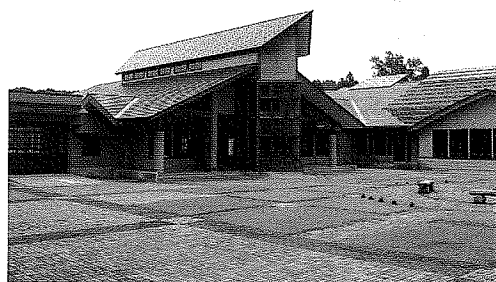
写真14 ほとんど被害の見られなかった越路西小学校
