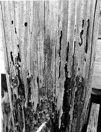
写真27 柱材の腐朽
