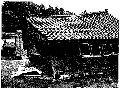
写真6 倒壊している非住宅部分
