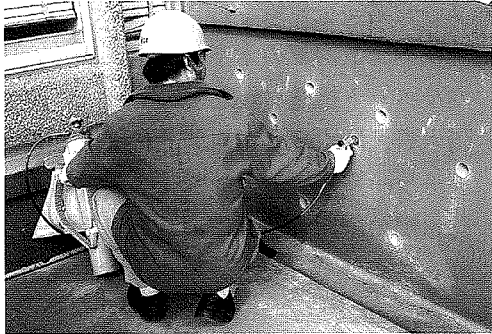
写真20 パラペット内部へ炭酸ガス製剤噴霧
