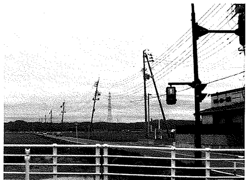
写真5 傾いた電信柱
