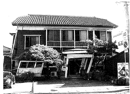
写真20 大きく傾く絵本館
