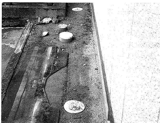
ステーション設置状況
