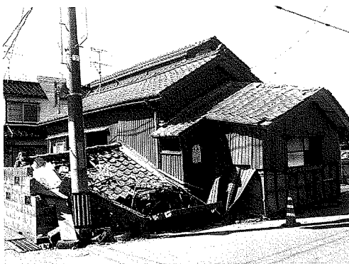
写真17 1階が崩壊している住宅
