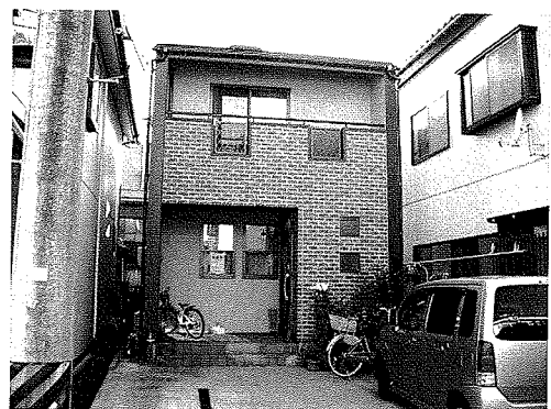
写真25 無被害の新築住宅
