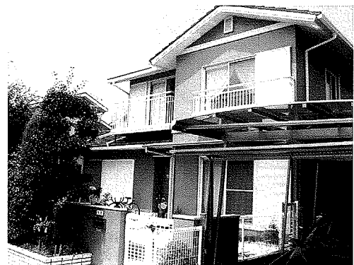
写真1 検知通報システムの施工を行ったY邸
