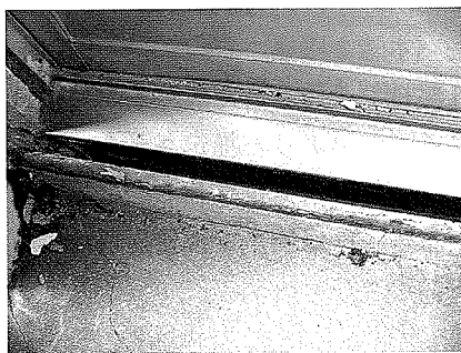
写真11 土台腐朽
