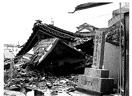
写真40 崩壊した潮音堂
