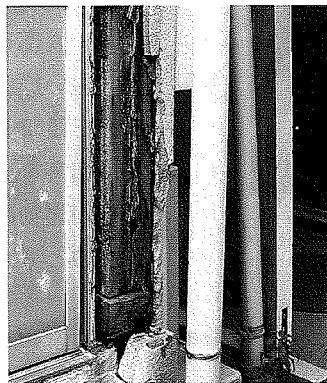
写真12 柱腐朽
