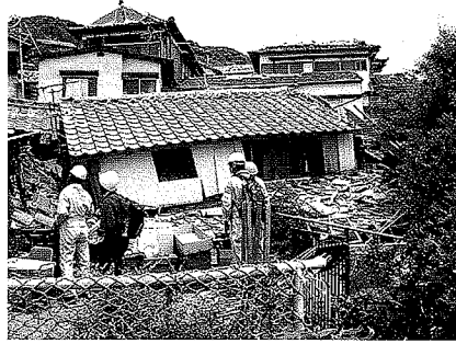
写真45 1階が崩壊し2階が1階に
