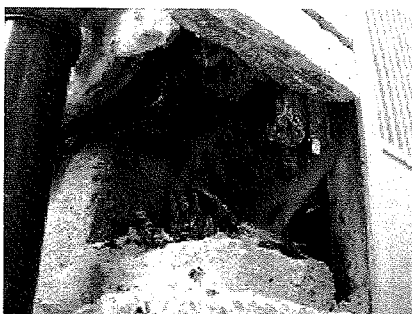
写真2 柱脚に蟻害
