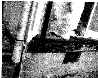
写真3 土台の腐朽
