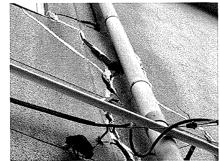
写真15 外壁亀裂
