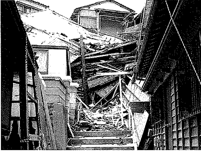
写真44 道を塞ぐ崩壊した家屋
