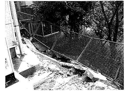
写真13 地盤崩壊
