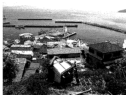
写真42 転落した倉庫
