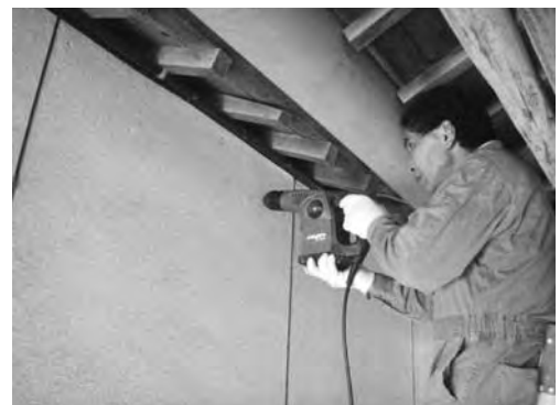
写真15 母屋 応接間⑦ (装飾があり、壁板が剥がせない部分については、外からモルタル壁を穿孔し、木部材への薬剤注入を行った)
