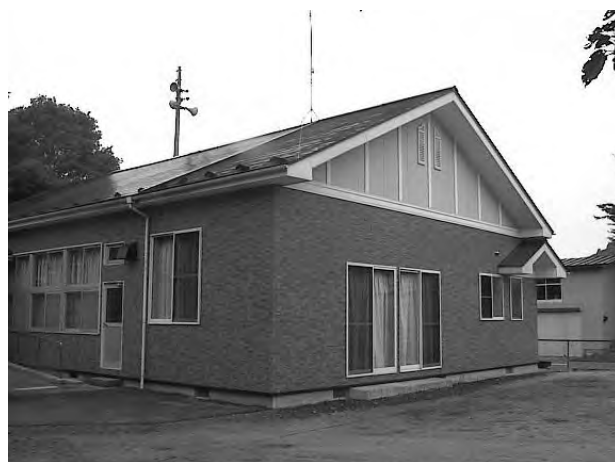
写真4 建物外観（増築されたホールとトイレ）
