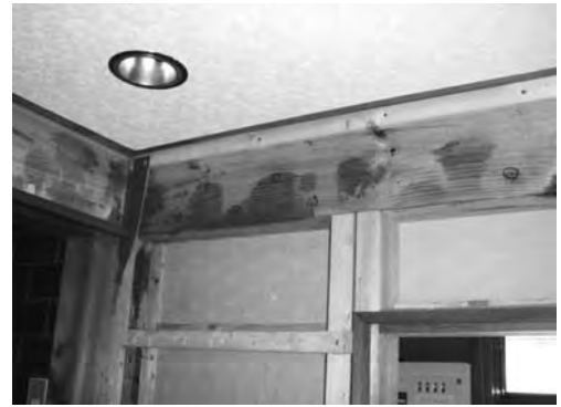
写真13 母屋 応接間⑥ (注入後の状況 (液垂れはほとんど無い))
