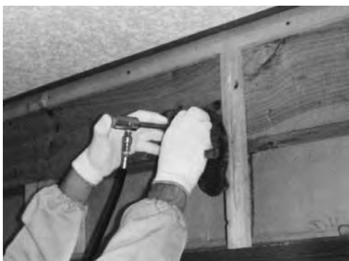
写真12 母屋 応接間④ (注入処理)
