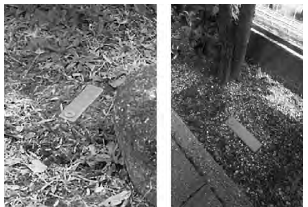
写真6 一般住宅に埋設
