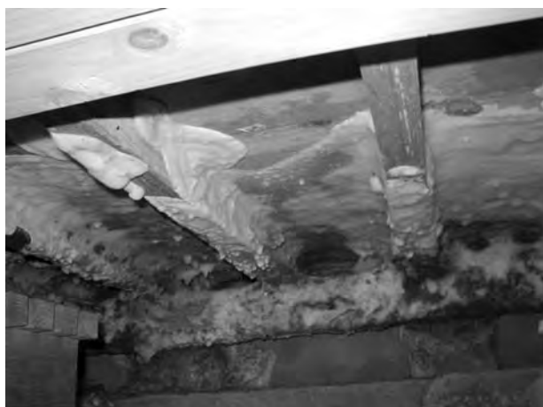
写真2 床下土壌面にも菌糸が生長している
