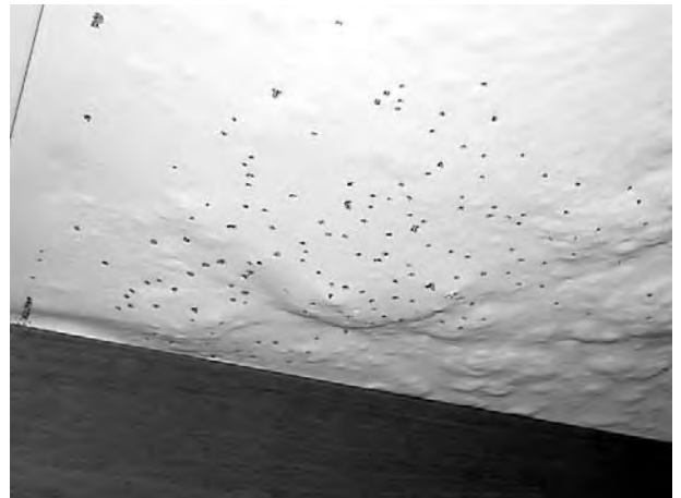
写真2 キャビン天井の分巣隆起と外気孔
