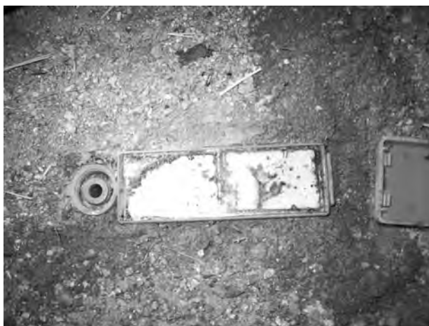
写真2 モニタリンググラス上からの確認
