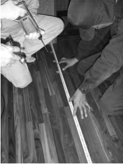
写真16 母屋 2F (応接間の上の2階の床から、床梁を穿孔処理)
