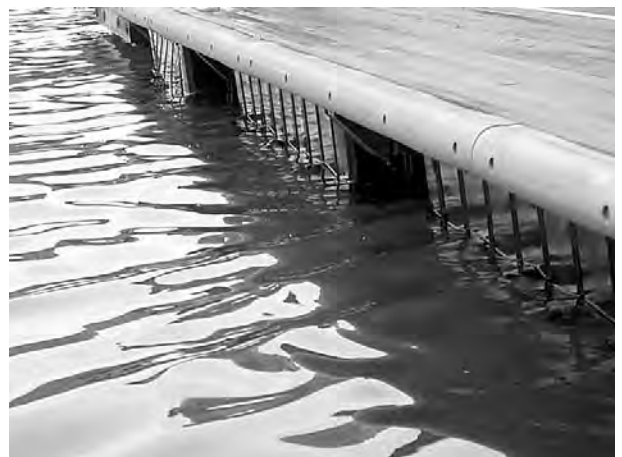
写真8 木製浮き棧橋外観
