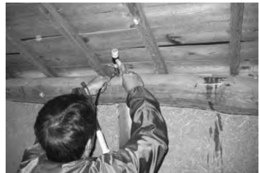
写真25 倉庫2F②（注入口金具打ちつけ）
