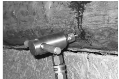
写真26 倉庫2F③（注入口金具）
