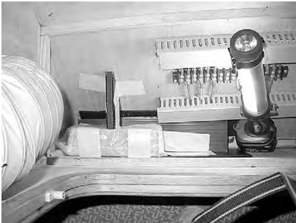
写真14 ロッカー底ボックス設置
