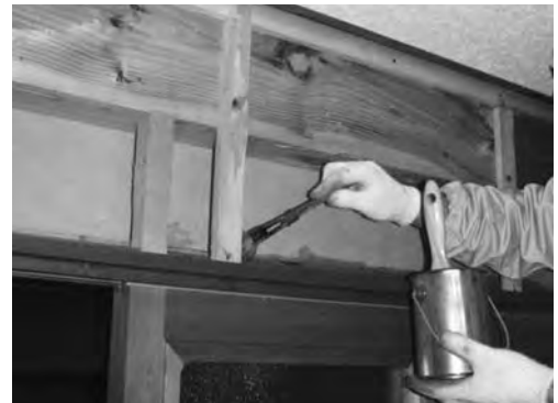
写真14 母屋 応接間⑤ (塗布処理)
