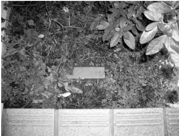
写真4 一般住宅に埋設
