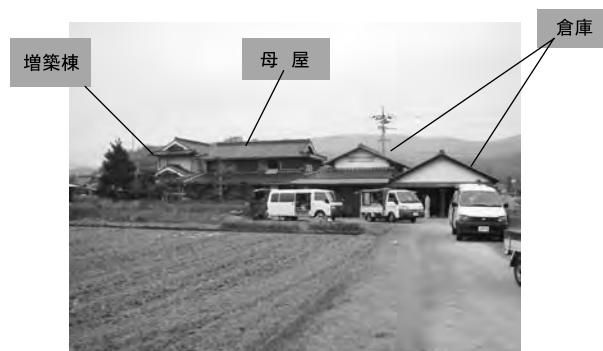
写真1 被害物件全景
