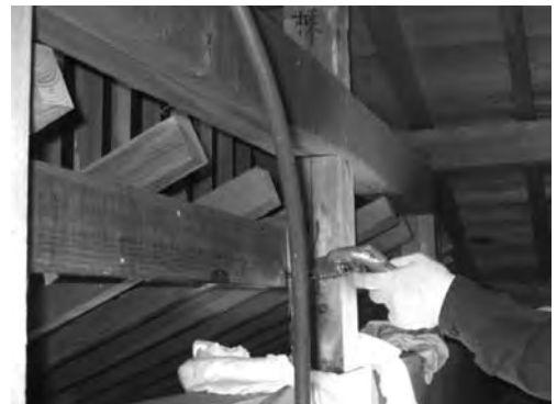
写真21 増築棟 天井裏① (天井裏はガンノズルにより注入処理を行った)
