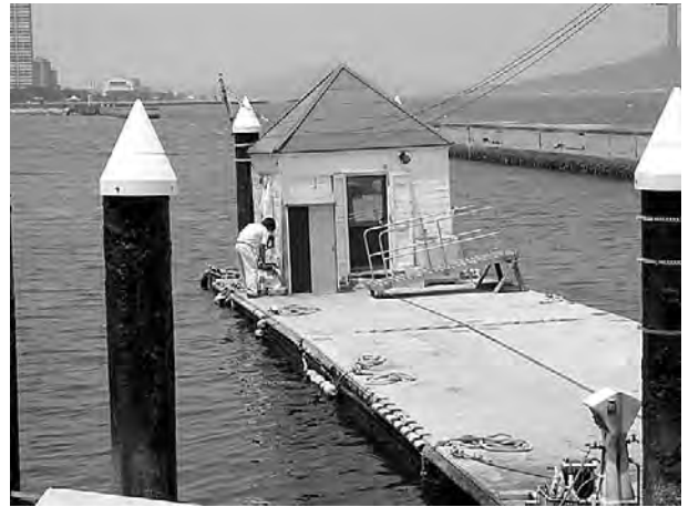
写真6 浮き棧橋外観
