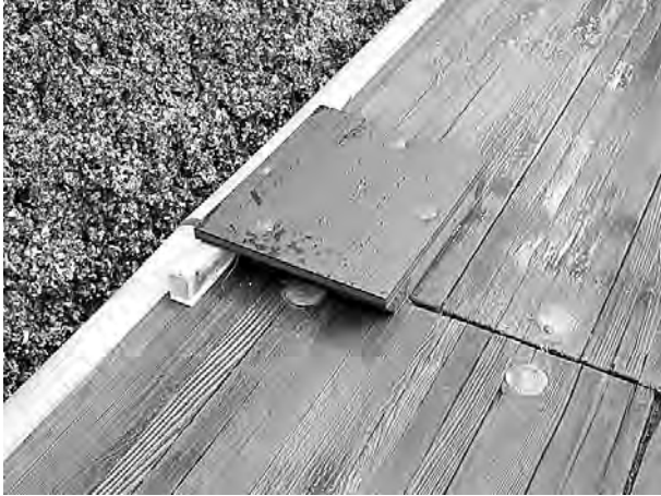
写真18 ボックス設置状況
