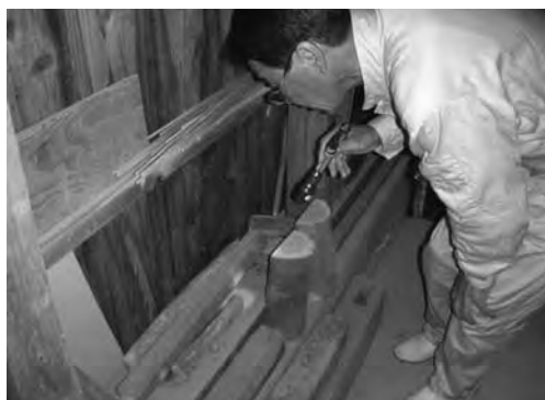
写真27 目視法による効力判定（2008年10月22日の調査時，薬剤処理箇所新たな虫糞の発生は確認されなかった）
