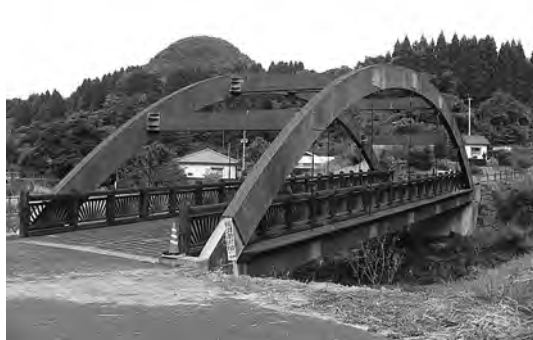
写真1 木製橋梁仙人橋
