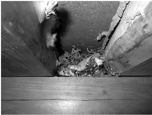
写真16 ねこ土台被害写真04-4 框内側蟻土
