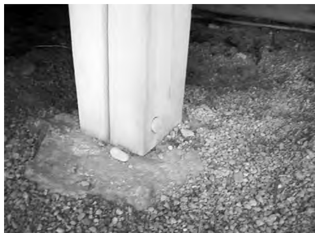
写真6 過去のシロアリ防除の痕跡 (木栓)
