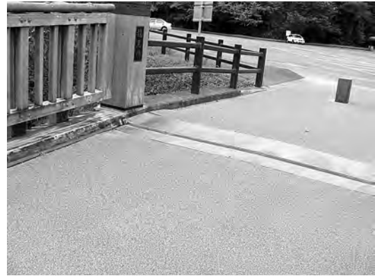
写真16 雨水対策の施された木橋
