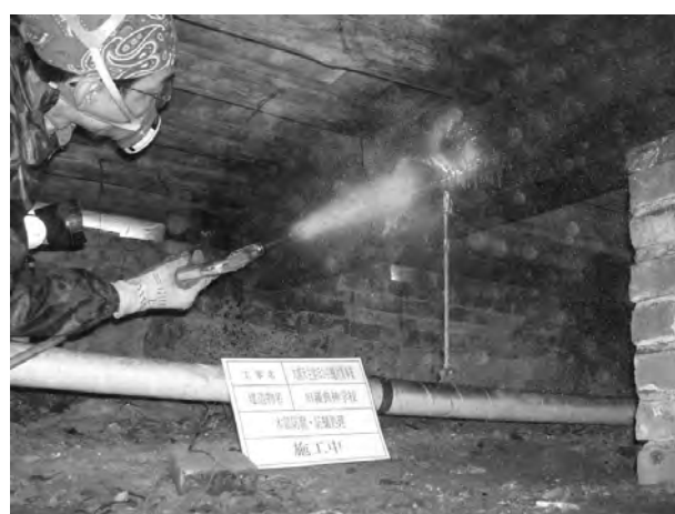
写真16 旧羅典神学校床下大引木部処理
