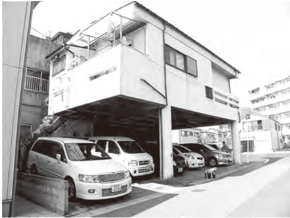
写真18 駆除した建物外観
