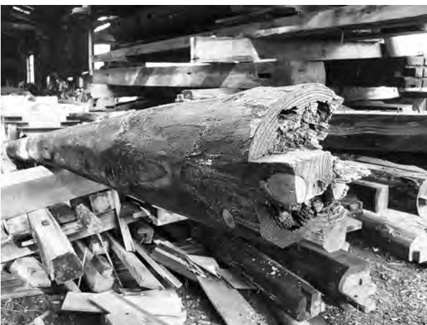
写真10 ブロッカー7 廃棄材 床組材(松)(杉)(桧)関係。クロタマムシ, ヤマトシロアリ, シバンムシ, 腐朽の複合被害。(甚大)
