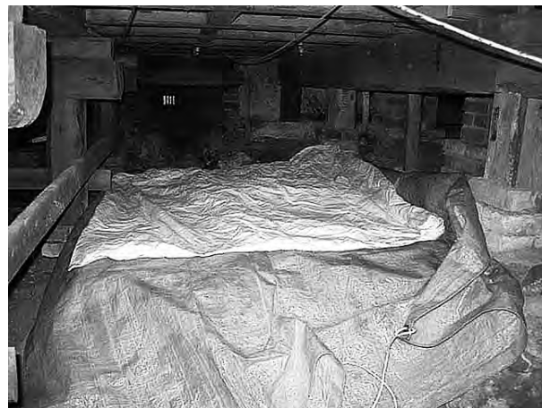
写真10 大浦天主堂点検口床下養生後
