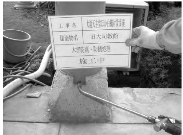
写真21 旧大司教館ポーチ柱木部処理
