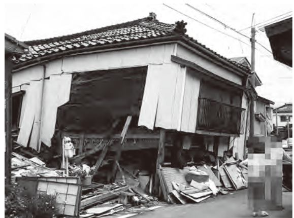
写真10 土壁、瓦屋根の重い古い住宅
