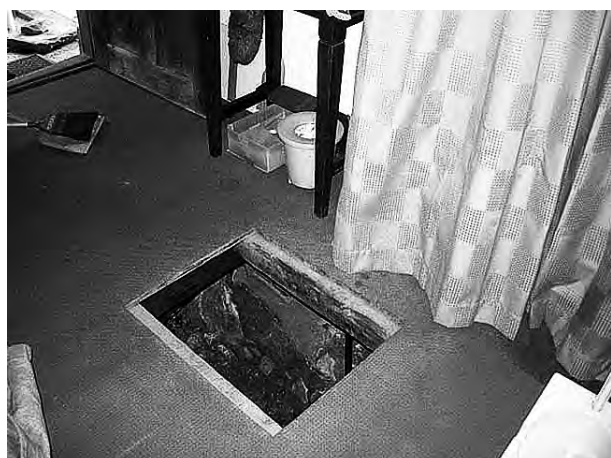
写真8 大浦天主堂床下点検口
