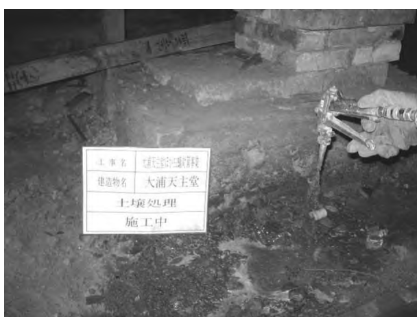
写真14 大浦天主堂床下土壌処理
