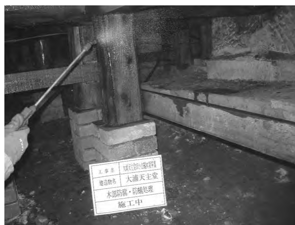
写真12 大浦天主堂床下束柱木部処理
