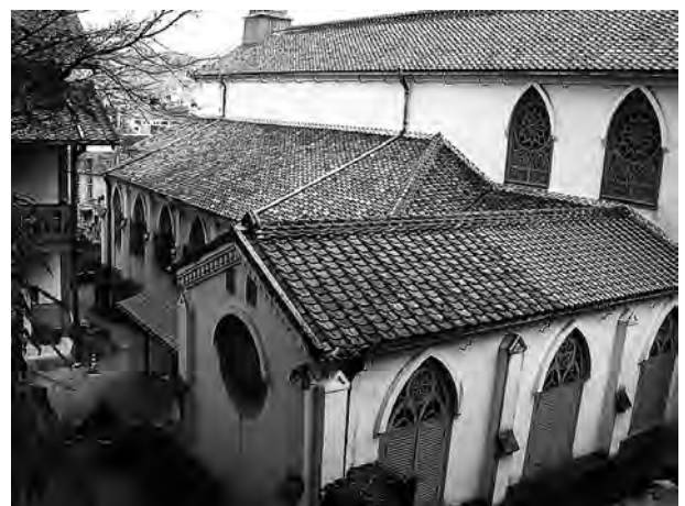
写真6 大浦天主堂屋根構造外観
