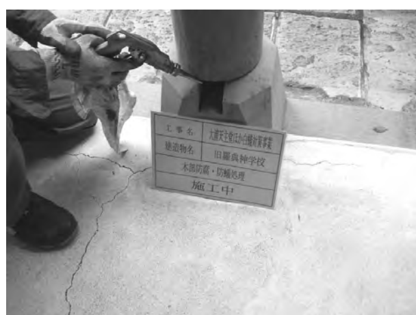
写真17 旧羅典神学校ポーチ柱木部処理
