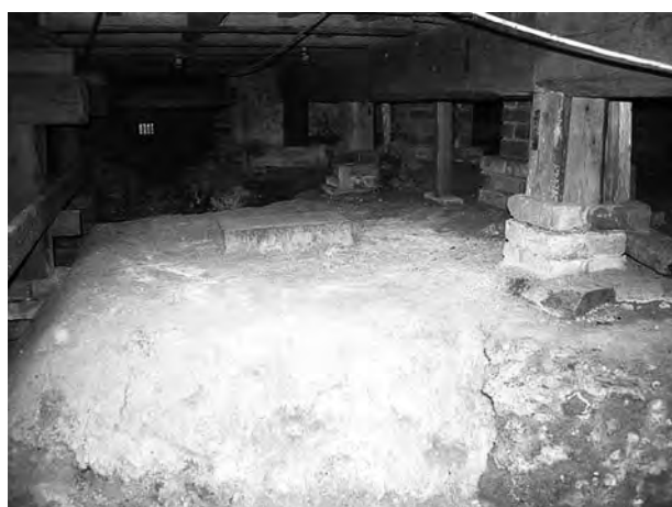
写真9 大浦天主堂点検口床下養生前
