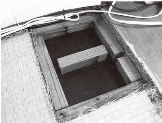
写真14 導入部を新たに設けたボックス
