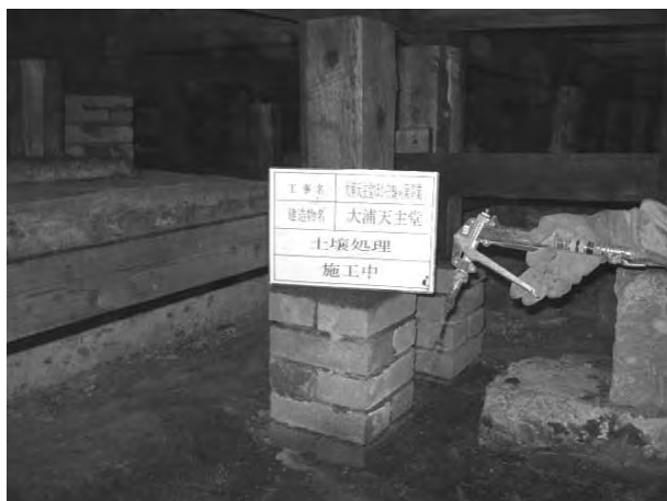
写真13 大浦天主堂床下床束廻り土壌処理
