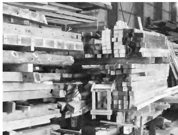
写真5 ブロッカー4 再生可能な解体材 梁、母屋、桁関係
