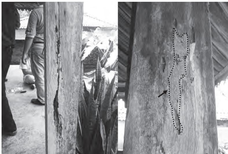
写真6 乾材シロアリによる柱の被害 (左) と食害部位の補修 (右)
