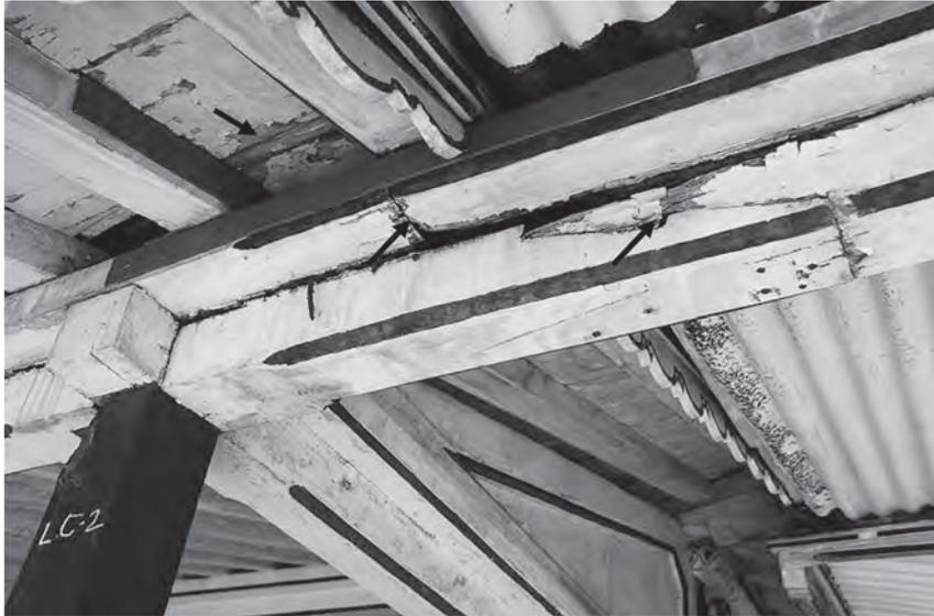
写真4 シロアリおよび腐朽による屋根材の被害
