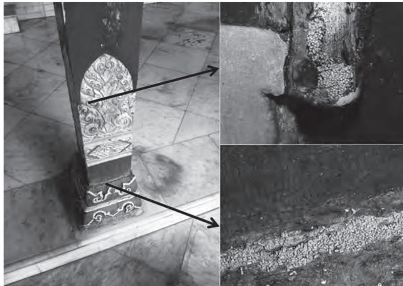
写真5 乾材シロアリによる柱の被害と虫糞の堆積
