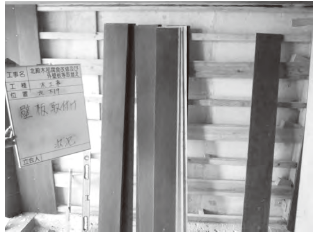
写真1 北殿の外壁工事の様子
