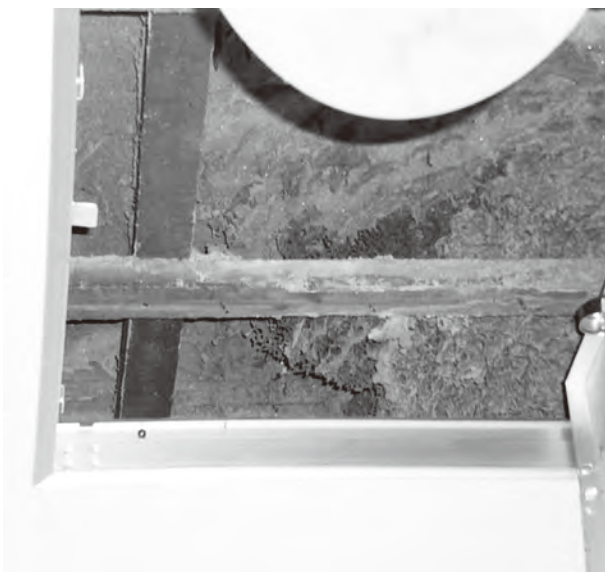
写真8 2階の天井のトップライト付近にできたイエシロアリの分巢。
