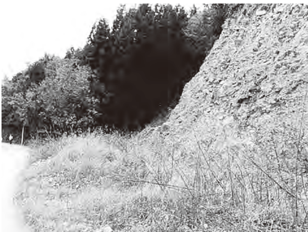
写真7 延岡市高野町切り土
