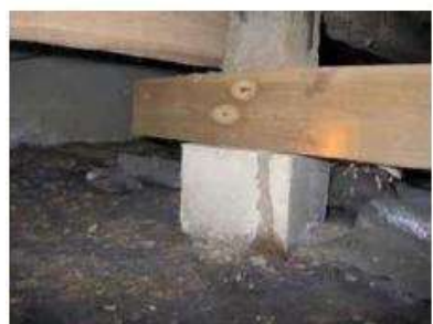
写真10 和室床下大引の蟻道・蟻土
