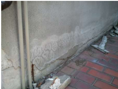
写真4 外壁塗装のはがれ
