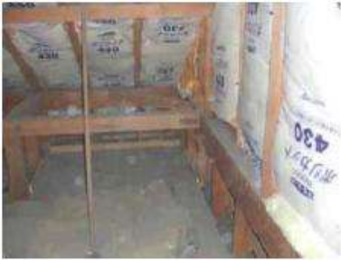
写真13 2階小屋梁、小屋束の食害
